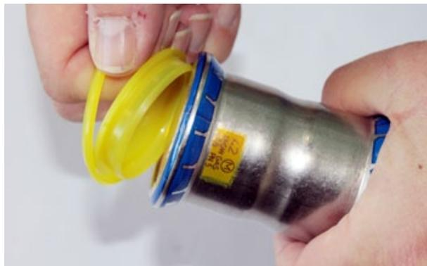
Bild 15: Entfernen der Schutzkappe und Prüfen des Dichtrings
