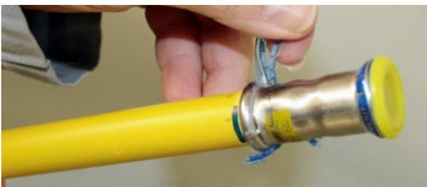
Bild 20: Pressindikator lösen
