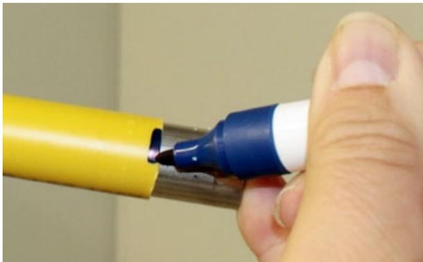
Bild 13: Markierung der Einstecktiefe bei Verwendung von Mapress Abmantelgerät
