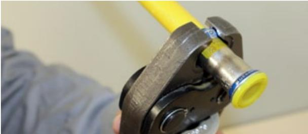
Bild 18: Pressvorgang mit Pressbacke  $d_a$  12 – 35 mm
